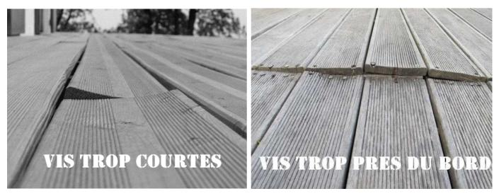
Le bois est un matériau vivant. Il se dilate et se rétracte en fonction de l'humidité. Il peut donc se déformer et engendrer des efforts importants sur les vis. Lesquelles doivent donc être d'au moins 2,5 l'épaisseur des lames. Sans quoi le bois éclate et la vis ne tient plus rien...
